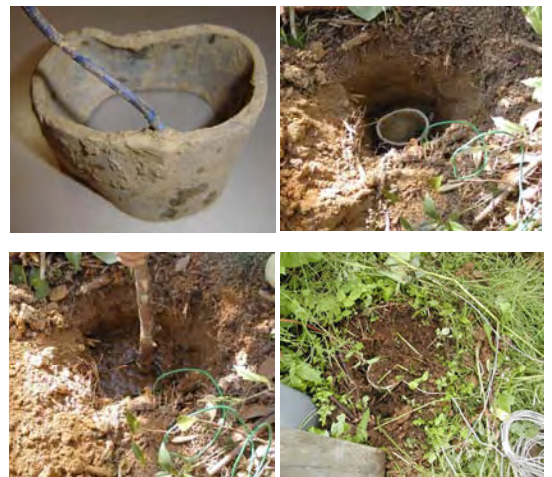
電極埋設状況
